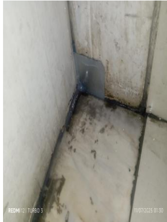
Support penutupan celah menggunakan plat seng
