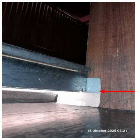
Dilakukan support penutupan celah akses menggunakan plat seng
